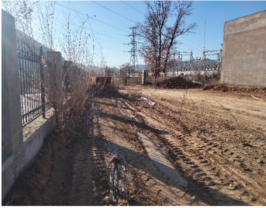
项目区进口现状
