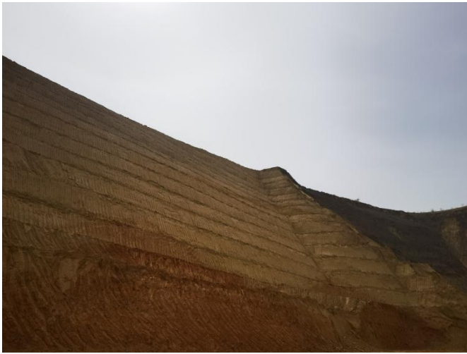
项目南侧现状
