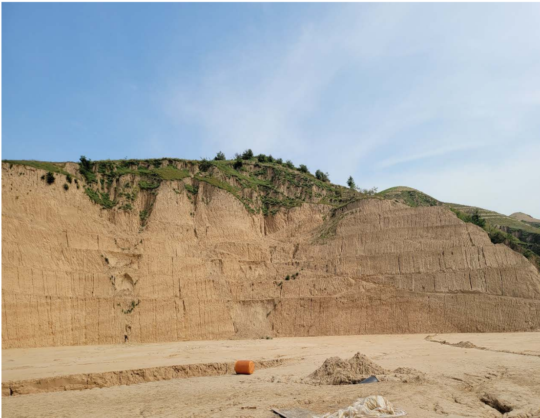
养殖区开挖现状
